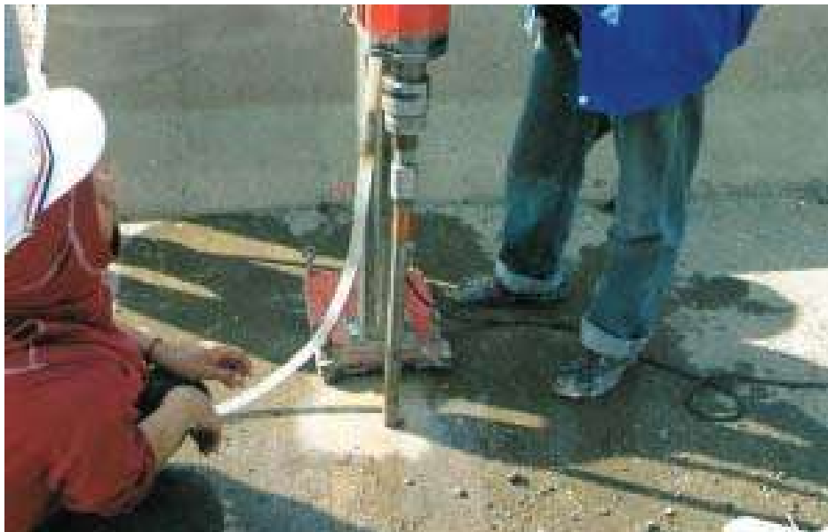
รูปที่ 2.8-4 การเจาะรูบริเวณพื้นสะพานเพื่อร้อยลวด PC Stand (จิตพันธ์, 2547)
