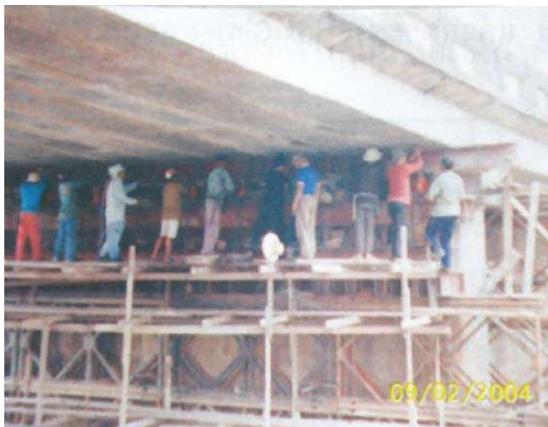
รูปที่ 2.8-8 การยกพื้นสะพานโดยใช้สะพานเบลีย์ (จิตพันธ์, 2547)
