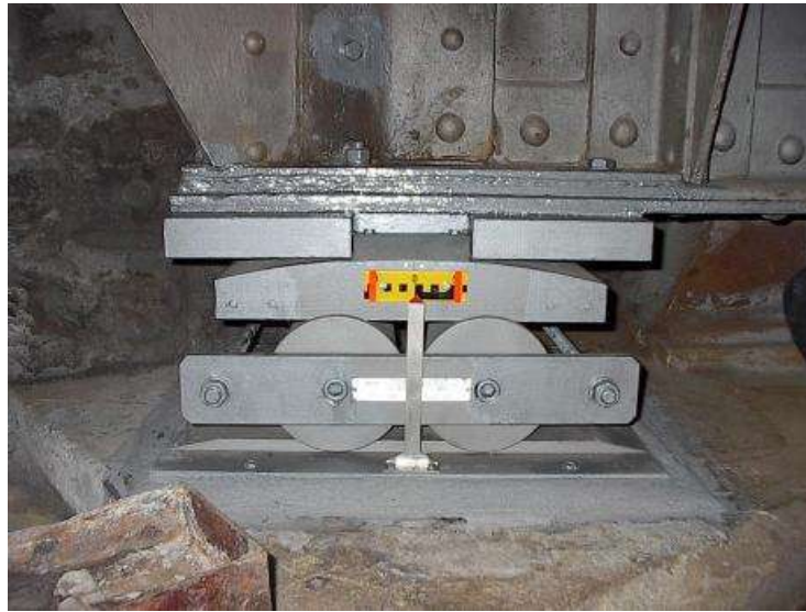
รูปที่ 2.1-2 Roller Bearing
