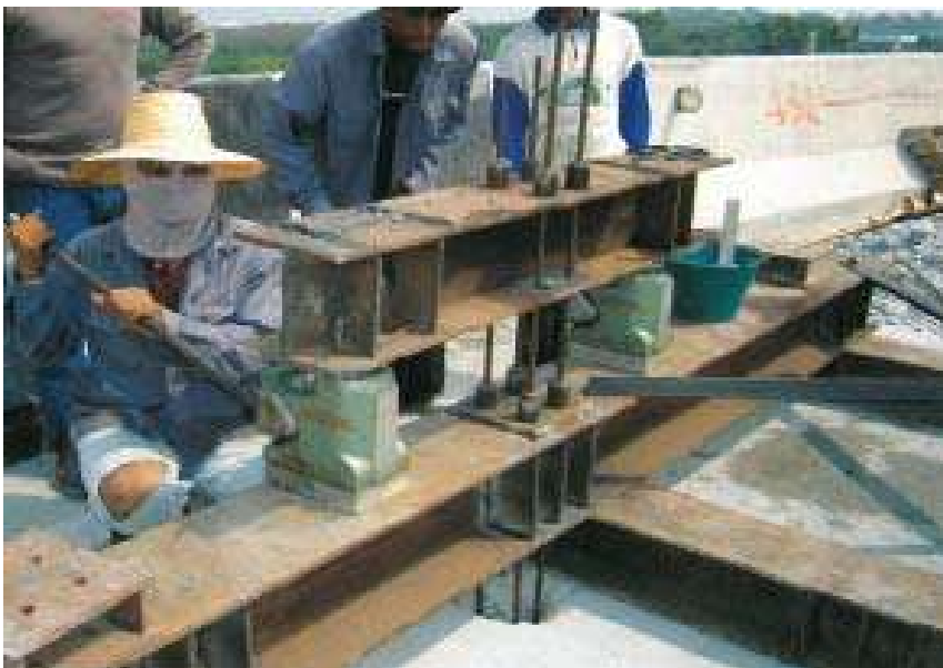
รูปที่ 2.8-7 การ Pre Load ลวด PC Stand (จิตพันธ์, 2547)
