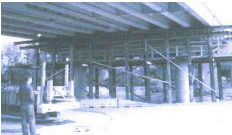
รูปที่ 2.8-1 การยกสะพานโดยใช้คานหมุน (AASHTO Maintenance Manual, 2004)
