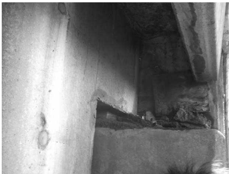
รูปที่ 5.1-3 กรณีพบสภาพแวลดล้อมโดยรอบมีความสกปรกต้องดำเนินการทำความสะอาดเอาสิ่งสกปรกออกก่อนจึงเริ่มทดสอบค่าความแข็ง
