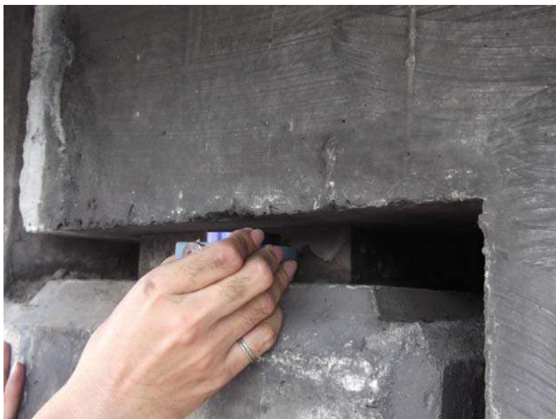
รูปที่ 5.1-4 กด Durometer จนแนบสนิทกับแผ่นยางรองคอสสะพานที่ทดสอบ
