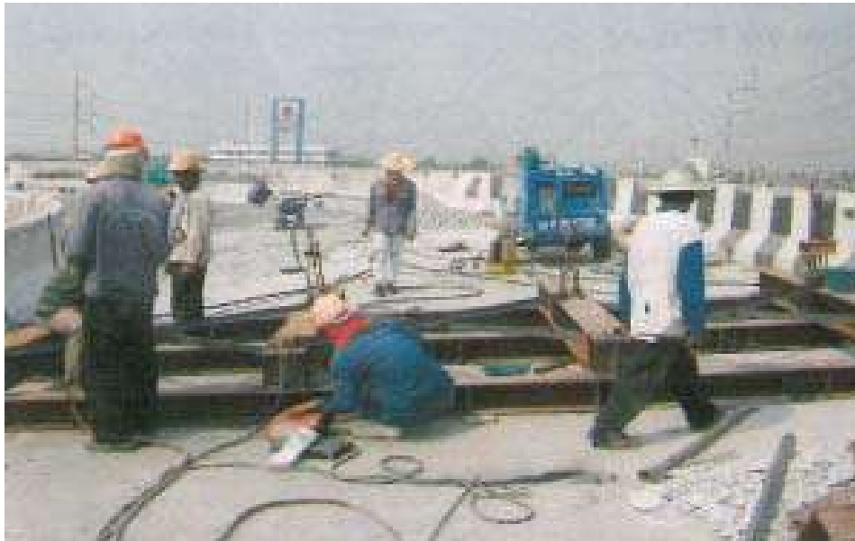
รูปที่ 2.8-5 การประกอบชุดยกสะพาน Carrier beam (จิตพันธ์, 2547)
